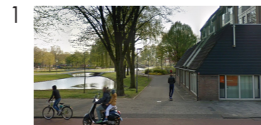
1 Het Zuidpark is een groot park in de stad, met woningen er vlak aan gelegen.
