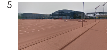
5 De parkeerplaats van Ahoy is een enorme plak asfalt in het gebied.
